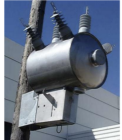
Figure 15 : Le VPR sur un poteau
